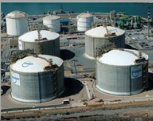
LNG Storage Terminal Barcelona, Spain
